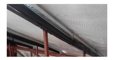
ระบบใต้หลังคาชิ้นนี้ประกอบด้วย แผ่นรองใต้หลังคาจาก วัสดุ PVC ซ้อนกับตาง่าย มีวิธีการติดตั้งง่าย ๆ เพียงแค่ ถอดช่องฝ้าเพดานออกหนึ่งช่องให้พอดีสำหรับช่างเง้าไปปู แผ่น Sheet และติดด้วยสกรูล็อกกับตาง่ายที่ใต้หลังคาได้เลย โดยในระหว่างติดตั้งทุกคนสามารถใช้ชีวิตประจำวันได้ปกติ ไม่ต้องมีการรื้อถอนหรือเคลื่อนย้ายสิ่งของแต่อย่างใด
