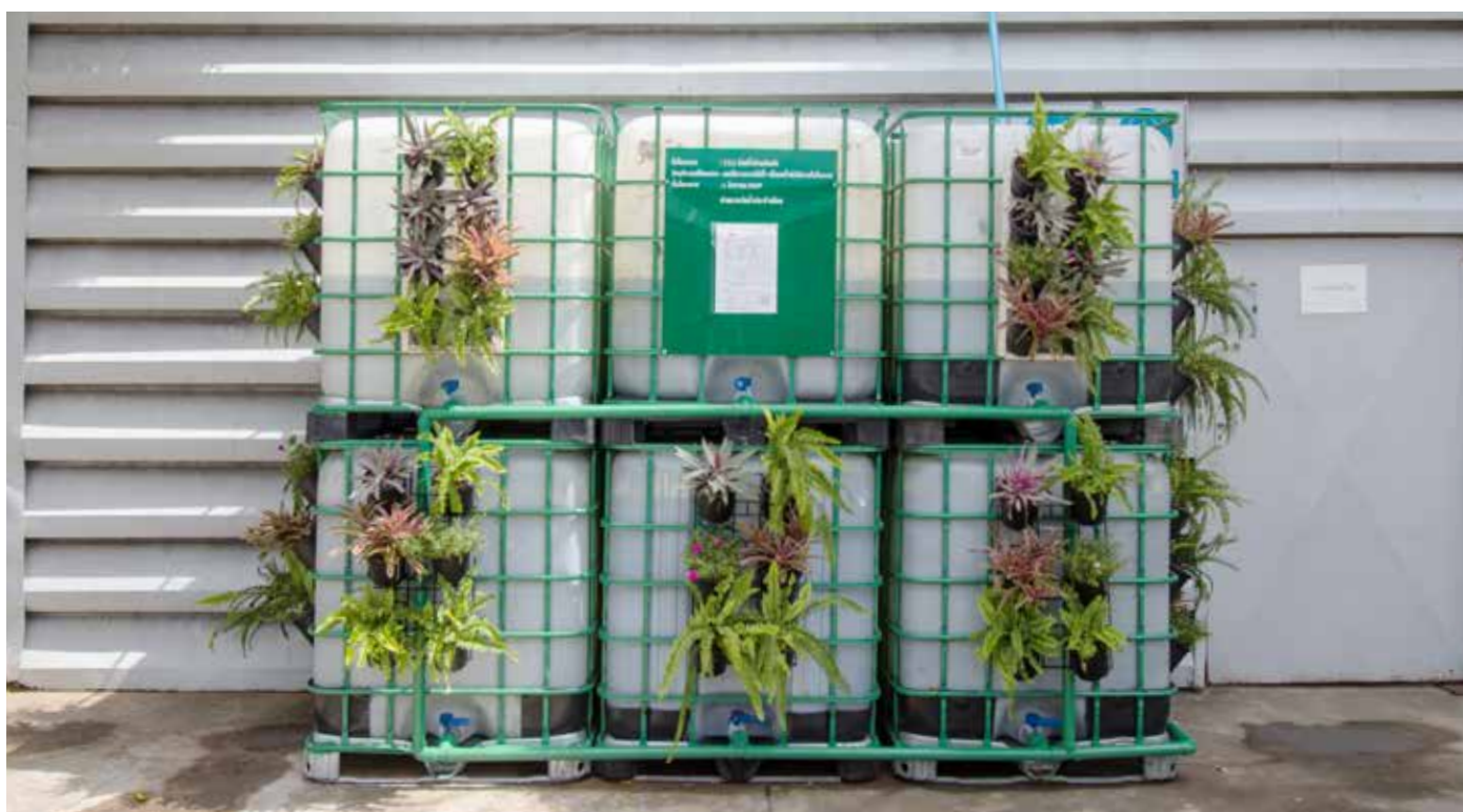
■ ถังเก็บน้ำที่ผ่านการบำบัดแล้วเพื่อนำไปรดน้ำต้นไม้ จากโครงการนำน้ำเสียจากกระบวนการผลิตกลับมาใช้ใหม่
