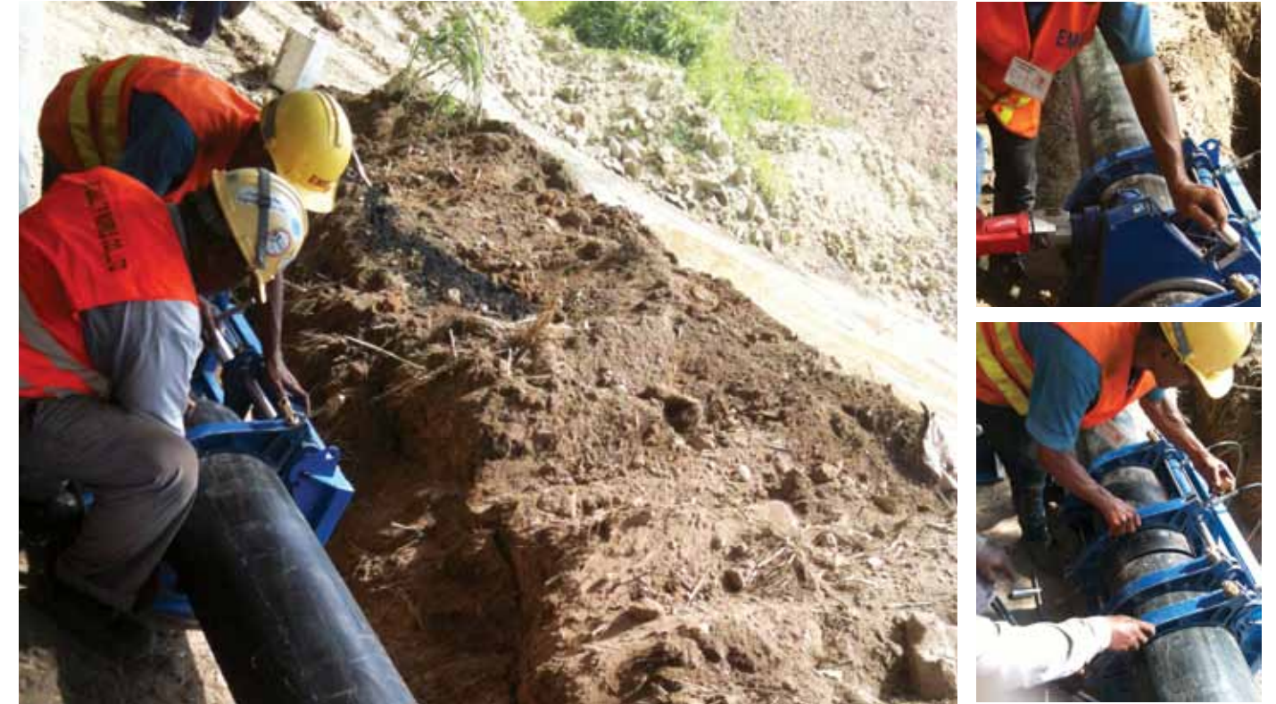
งานวางระบบประปาด้วยท่อ HDPE
