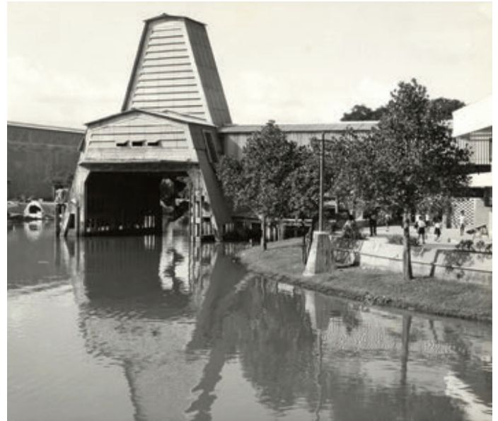
อาคารกสิยวหมู่ (Loading Center) โรงปูนบางซื่อ Loading Center, Bang Sue cement factory
