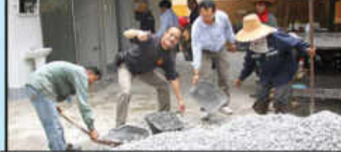
โครงการสร้างห้องน้ำผู้พิการและปรับปรุงห้องน้ำ ให้ถูกสุขลักษณะ วัดโสภณ
