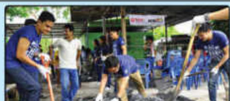
โครงการศูนย์รวมเด็กด้อยโอกาส ปกตจากจาเสด็จ (ปรับปรุงต่างพวก) ชุมชนชองประปา
