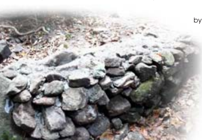
ฝายชะลอน้ำที่เสร็จสมบูรณ์แล้ว Check dam
